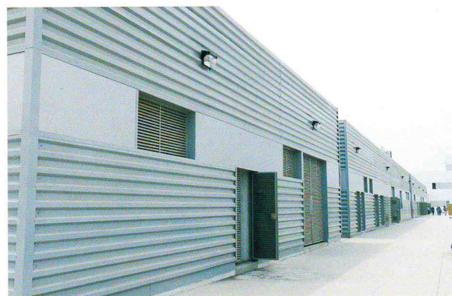
Pabellones de servicios.
