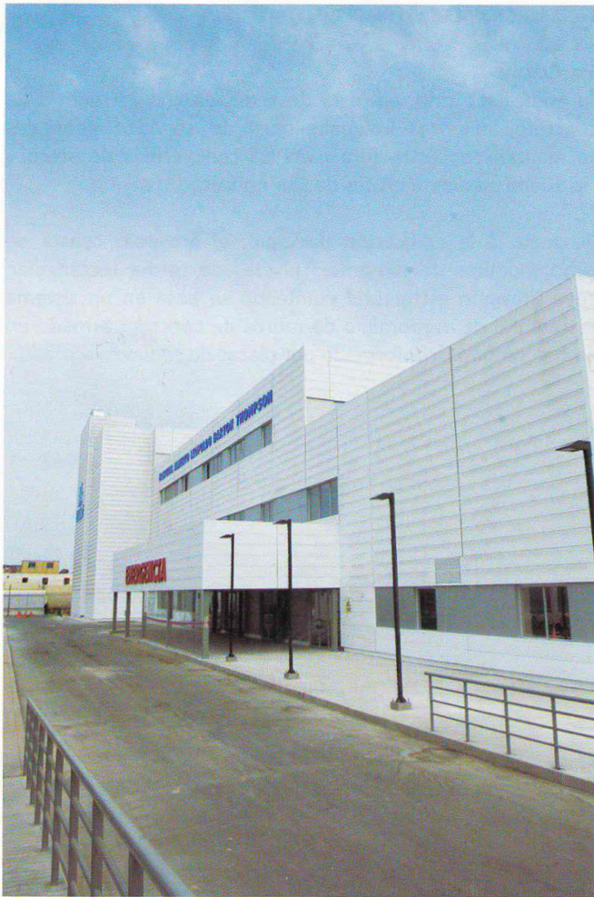
Fachada hacia la Av. Argentina, donde se encuentra el acceso de Emergencias.
