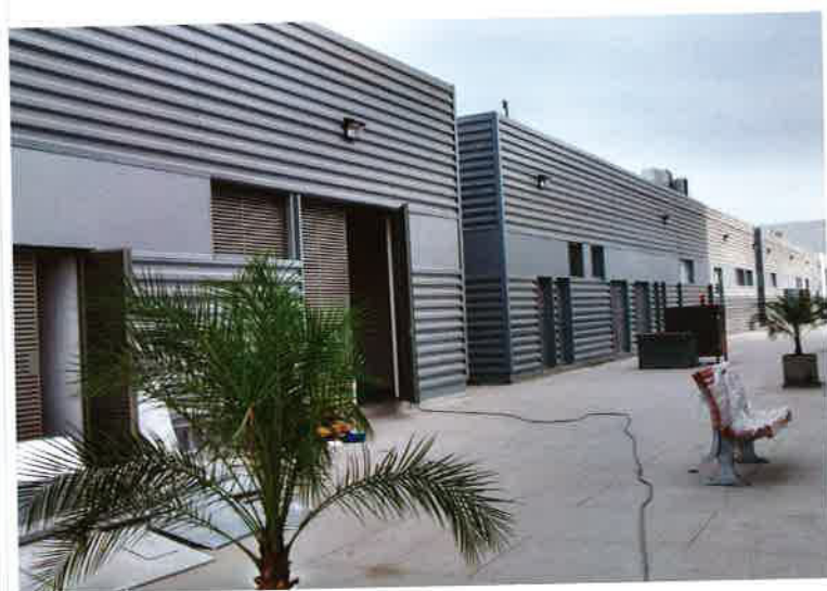
El proyecto contempló tres naves de estructura metálica correspondiente a la morgue, almacén y casa de fuerza, los cuales se ubican en la parte posterior del hospital.
