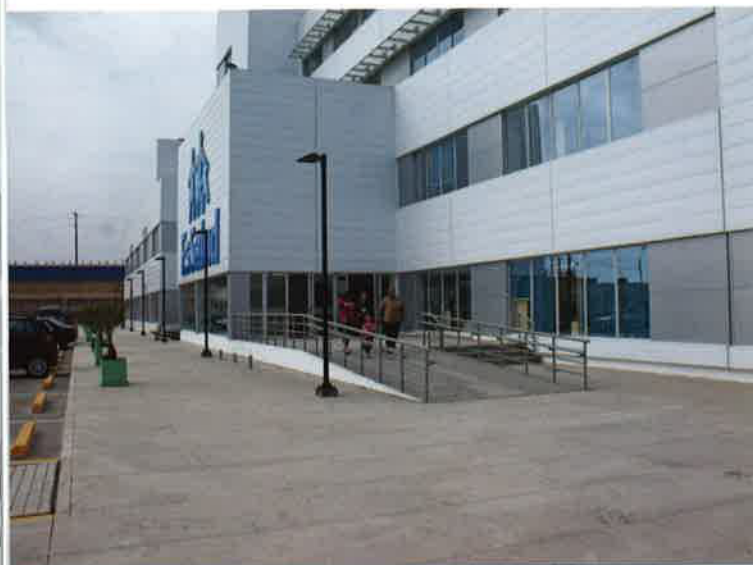
Rampa de acceso al sector B del hospital. Vista de los rompesoles colocados de manera horizontal sobre los vanos.
